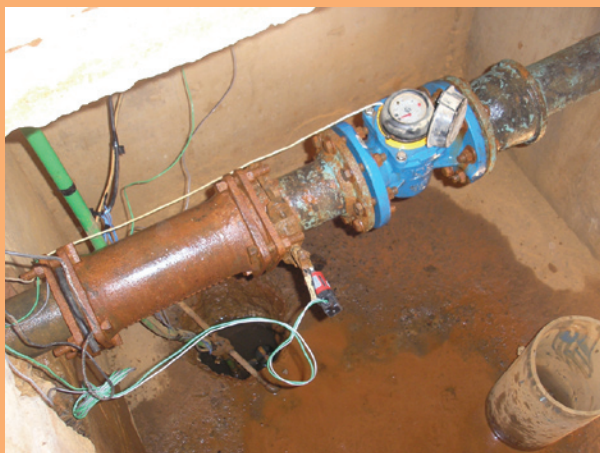
A macromedição e o controle de pressão de vazão na rede são dois procedimentos importantes para o combate às perdas de água nos sistemas de abastecimento
